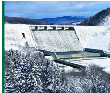
サンルダム 北海道 2019年3月竣工
