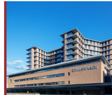
石川県立中央病院 石川県 2017年9月竣工
