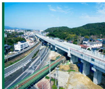
九州新幹線 宇都高架橋 長崎県 2021年3月竣工
