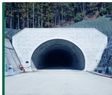
中部横断自動車道 大島地区トンネル 山梨県 2019年2月竣工
