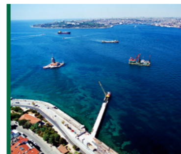
ボスボラス海峡横断鉄道トンネル トルコ イスタンブール市 2014年10月竣工
