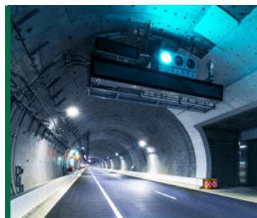
首都高速道路 横浜北西トンネル 神奈川県 2019年12月竣工
