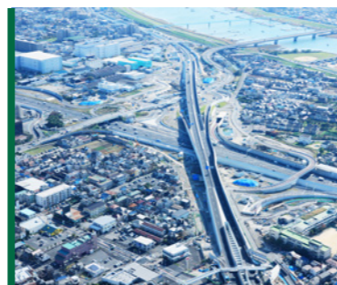
東京外かく環状道路田尻工事 千葉県 2019年6月竣工
